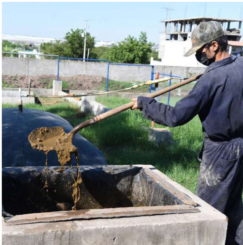
Fotografía: Propia del autor.
